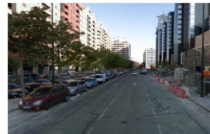
Deterioro de calzadas por obras.
