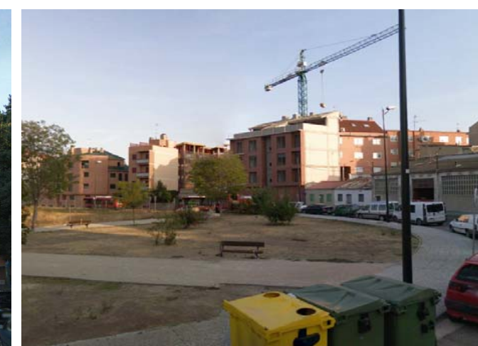
Zonas de recreo deterioradas
