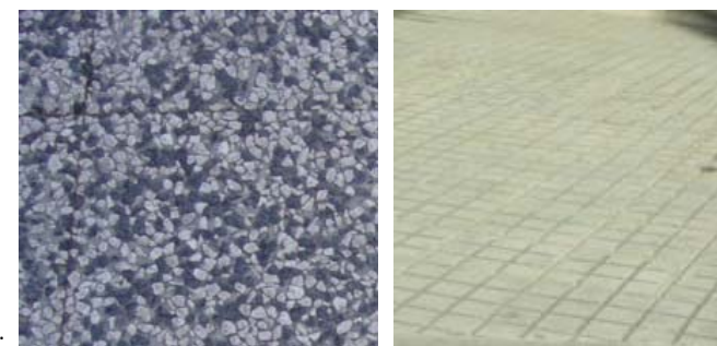
Pavimentos de acera en distintos tramos de la calle
