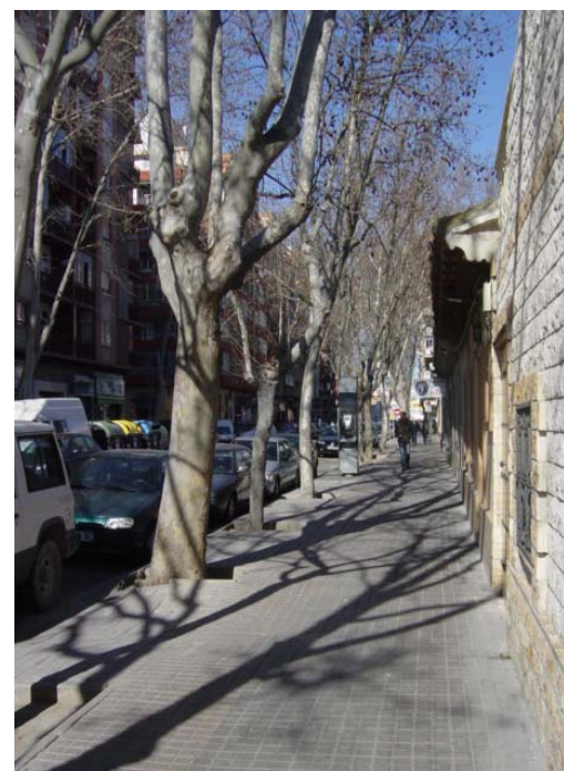
Arbolado de gran porte sin protección de alcorques y deterioro del pavimento a causa de las raíces
