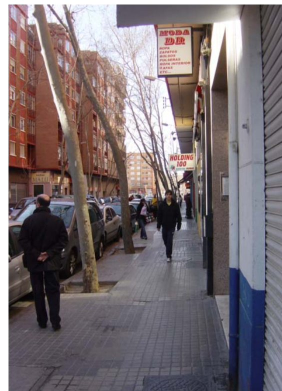
Arbolado de gran porte con alcorques sin protección y pavimento en mal estado de conservación.
