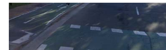
Carril bici en la vía
