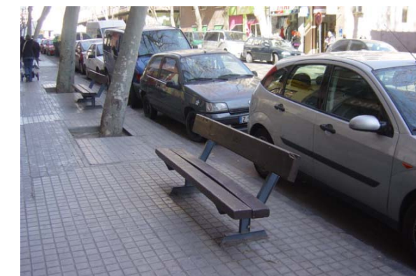
Mobiliario urbano deteriorado
