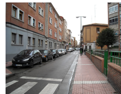
El tramo inicial presenta una zona verde de baja calidad de urbanización vinculada al conjunto residencial.
