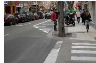
La pintura vial muestra un estado deficiente en ciertos tramos, con rebajes de bordillo para accesibilidad.
