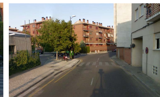
Zona de la vía donde no está permitido estacionar
