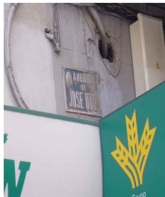
Señalización urbana en mal estado
