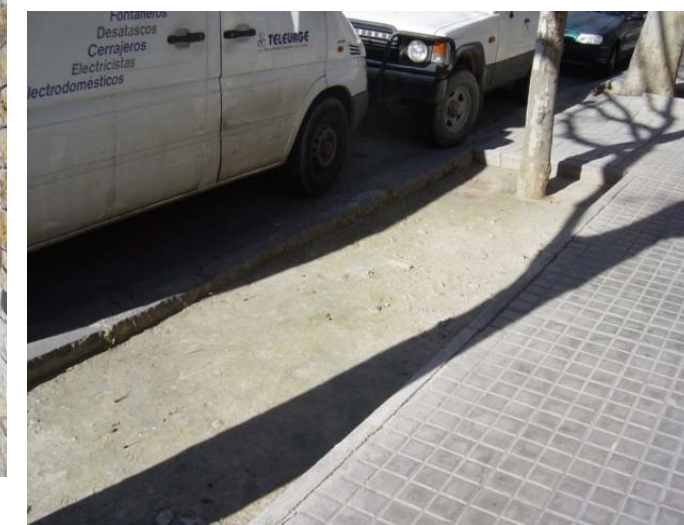
Alcorques longitudinales con falta de ornamentación floral y protección
